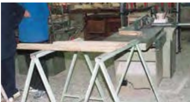
شکل ۱-۴۶-۱- قطعات چوبی آماده.
