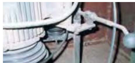
شکل ۳-۱۴- باز کردن درپوش (روی تسمه‌ها).
